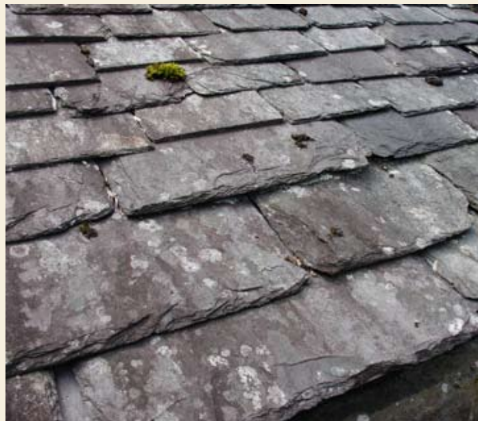
Verweerd dak van leesteen.
